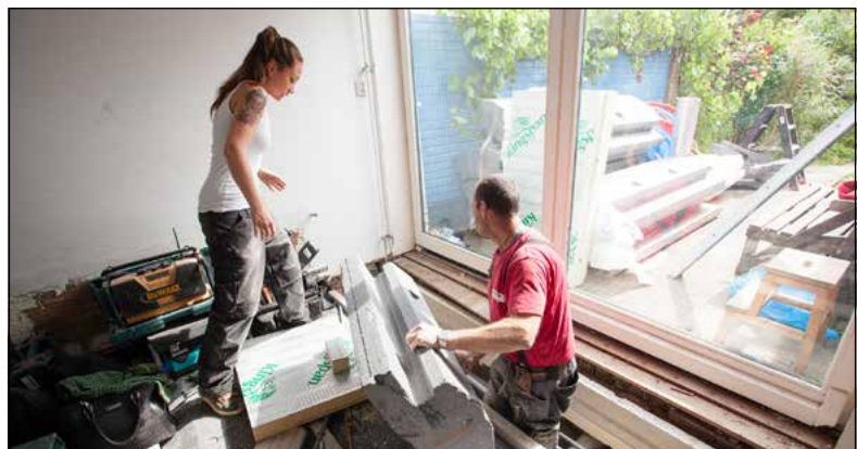
De renovatie van een oudere woning naar NOM (foto: Bernard Faber)
